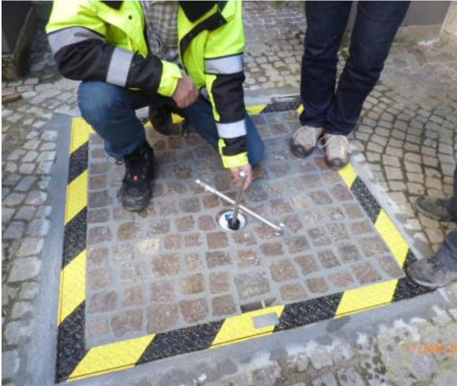
Bild: Autorisierung nach Energieerzeugung an einer Hochsicherheits-Schachtabdeckung (RC4/6)
