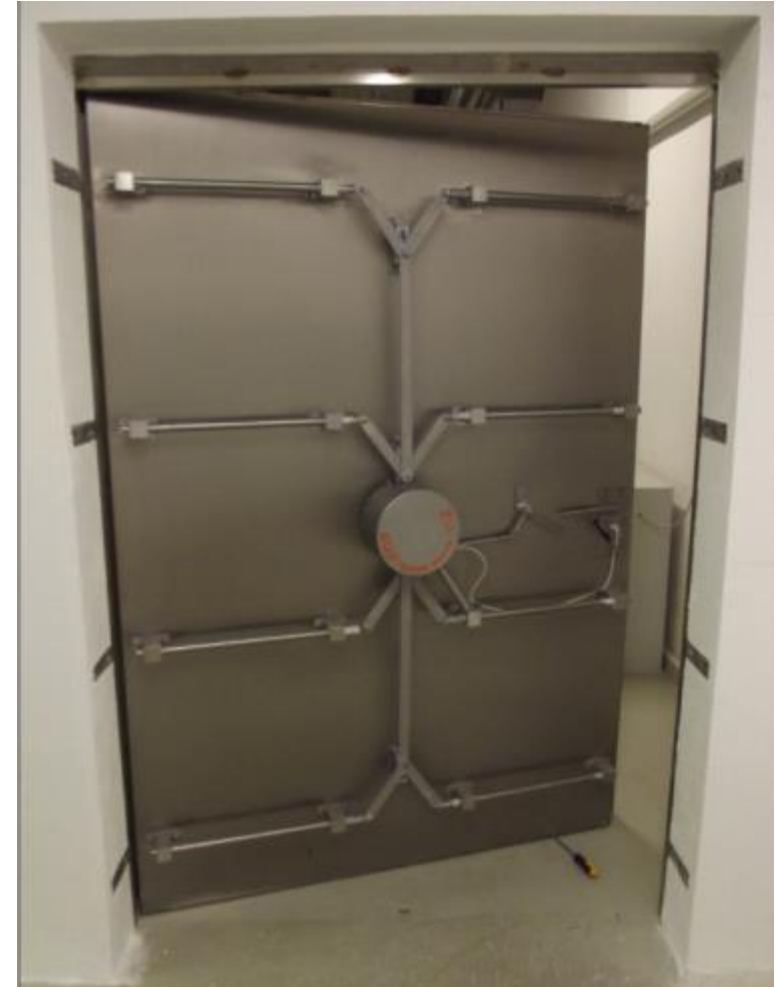
Bild: Ansicht Hochsicherheitstür (RC4/6)
